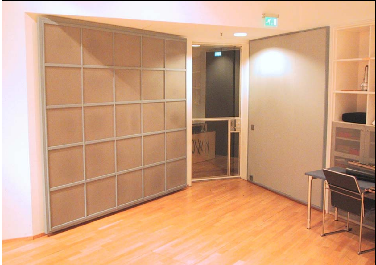
Kuva 4. Orkesterisalin etunurkasta syntyvät äänikeskittymät ja äänen paikallistuminen väärään paikkaan on estetty vaimentamalla nurkan sileät seinäpinnat.
